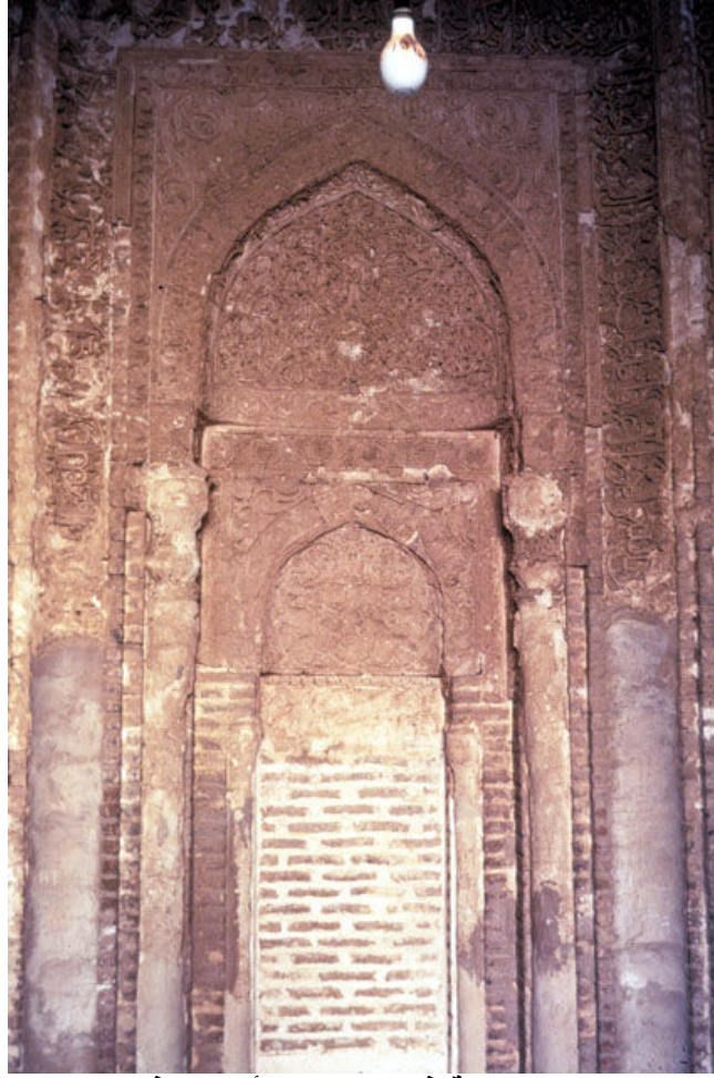
لوحة رقم ٢١. محراب مسجد الجمعة في زواره: الأضرار في المحراب وطريقه الترميم الغير مدروسة (مسجد زواره)
